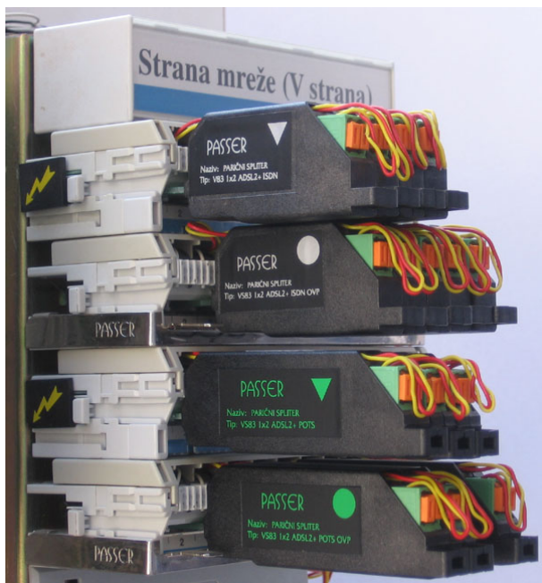
Sl 4 : Prikaz montiranih jednoparičnih splitera sa i bez integrisane zaštite na glavnom razdelniku
